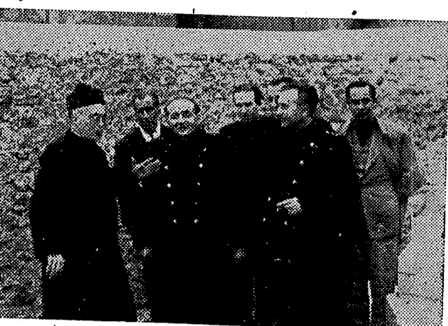
Apenas levantadas las tapias que cercaban los trabajos en los cimientos, D. Joaquín Balaguer pensaba ya solo en la Iglesia y su reconstrucción; y cada visitante de Castellón, como en este caso Juan Aparicio, por 1943 Delegado Nacional de Prensa, era llevado al solar sagrado y escuchaba de labios del Arcipreste explicaciones sobre la asombrosa empresa acometida por nuestro pueblo bajo su guía.
