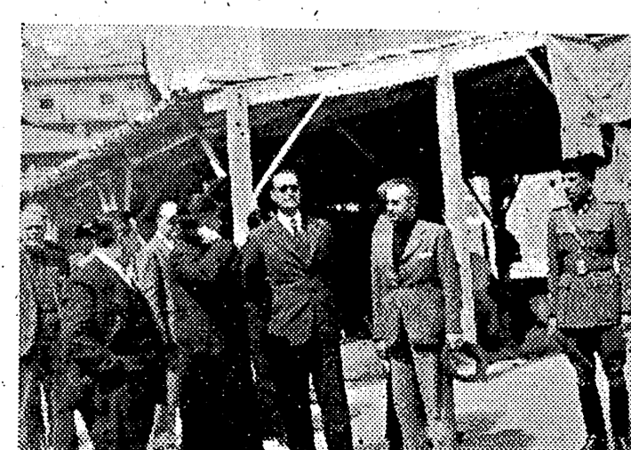
Antes de abandonar Castellón el Ministro, acompañado del camarada Andino, Cura Arcipreste y otras autoridades y miembros de la Junta Procuradora, visitó las obras de reconstrucción de la Arciprestal quedando muy complacido del esmero que representa y habiendo reiterado anteayer a nuestro Jefe y Gobernador sus vivos deseos de ayudar a que los trabajos continúen con ritmo cada vez más rápido. (Foto Gil Roca)
