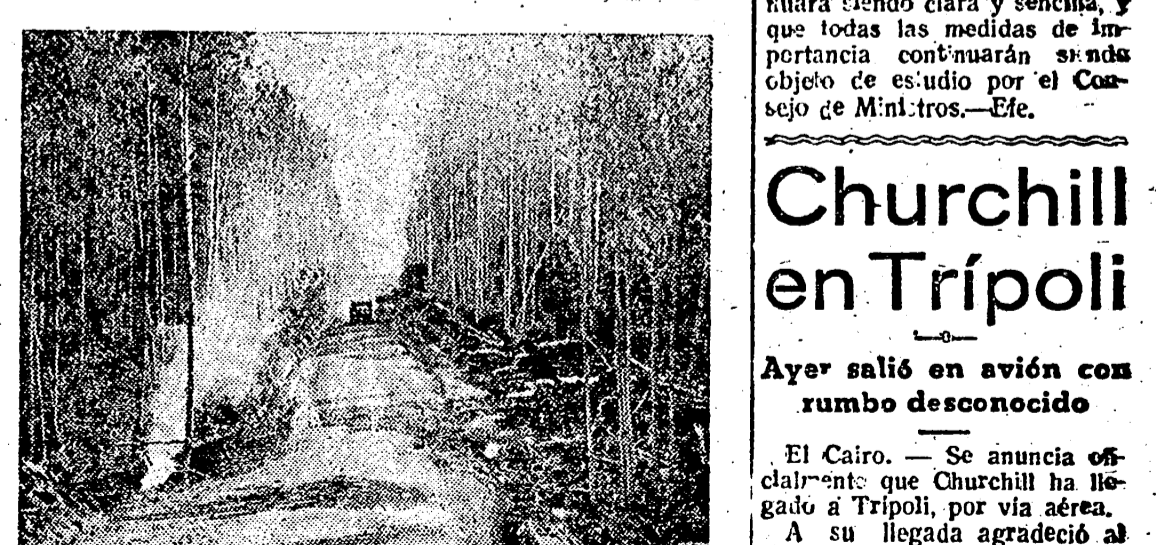
Para mejorar sus comunicaciones y asegurar mejor la defensa del Norte de América, los Estados Unidos han construido, rápidamente, la nueva carretera de Alaska, que cruza bosques enormes. Eminentemente esta carretera es llamada en América alta ruta hacia Tokio. Hoy por lo menos parece el modo un poco prematuro.
