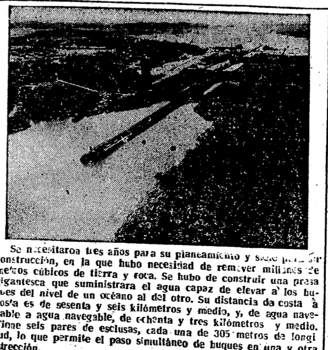
Se necesitaron tres años para su planeamiento y construcción, en la que hubo necesidad de remover millones de metros cúbicos de tierra y roca. Se hubo de construir una presa que permitiera el paso simultáneo de buques en una y otra dirección.
